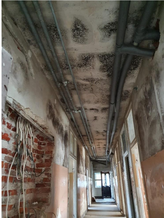
Rys. 7. Niezabezpieczona instalacja elektryczna
