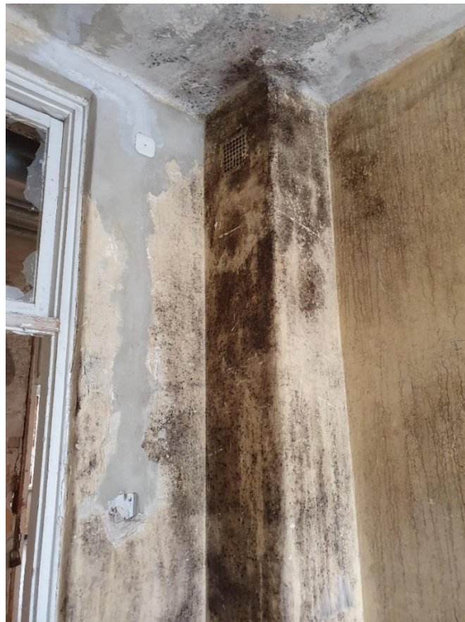
Rys. 10. Odspojenia tynku, stolarka drzwiowa do wymiany
