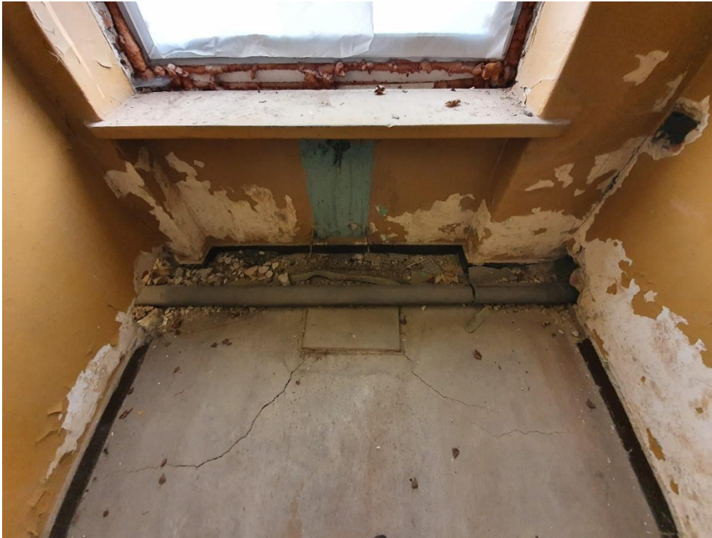
Rys. 9. Spękania posadzki
