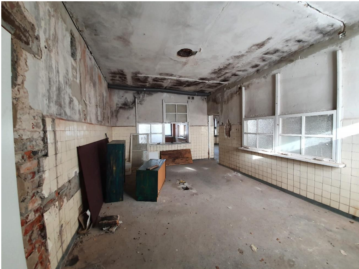
Rys. 1. Pomieszczenie zmywalni – ubytki w ścianach
