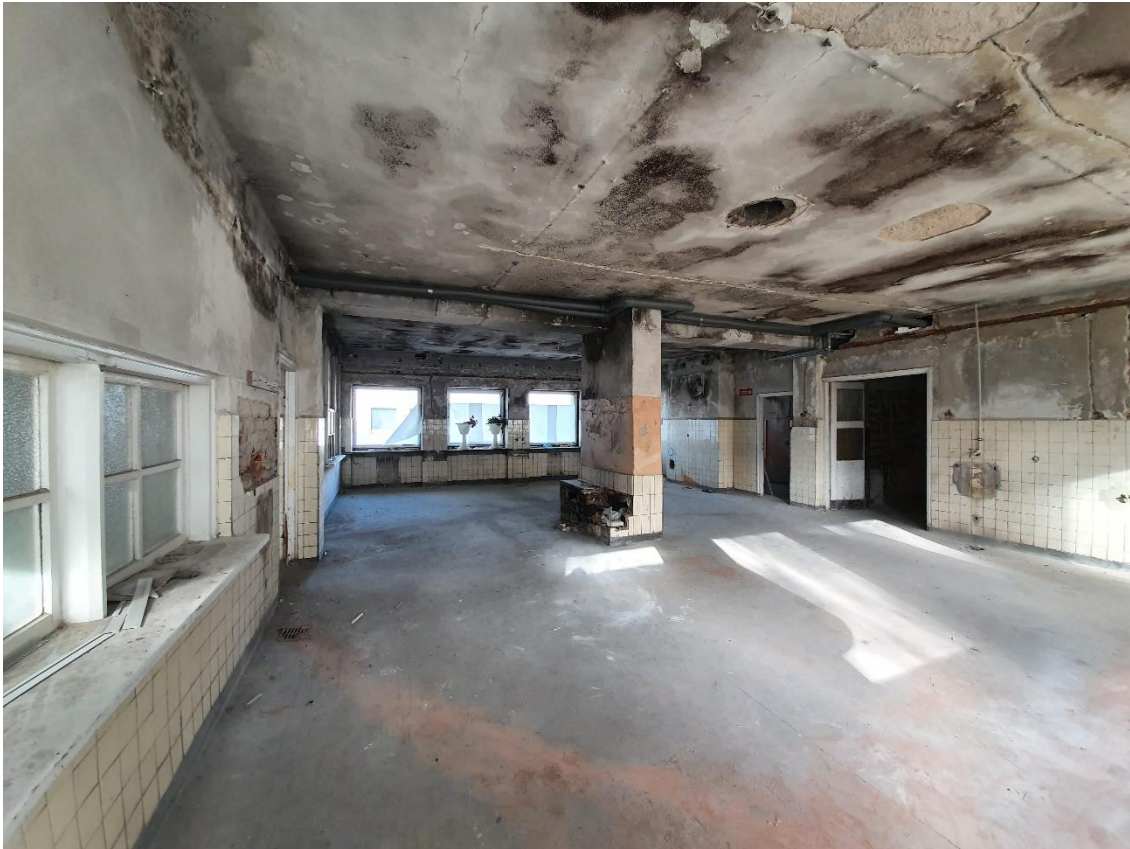
Rys. 3. Pomieszczenie kuchni – ubytki w ścianach, zawilgocenia.
